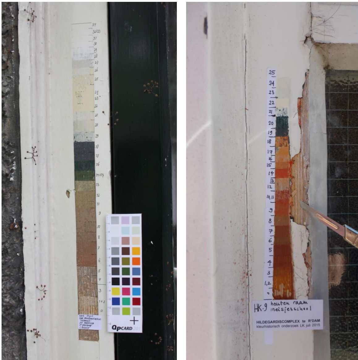
Fig. 4. Voorbeelden van een kleentrap of stratigrafie. Links op een kozijnstijl van het Duivenhuis in Artis te Amsterdam, rechts op een raam van de Hildegardis meisjesschool te Rotterdam.
