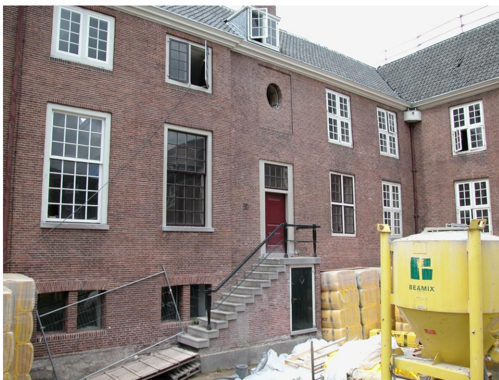
Fig. 15. Boven een voorbeeld van het vinden van de geschikte kleurstaal bij de vrijgelegde historische kleur. Onder een voorbeeld waarbij een proefopzet is vervaardigd op een deel van de gevels ter beoordeling van architect, opdrachtgever en kleuronderzoeker.
