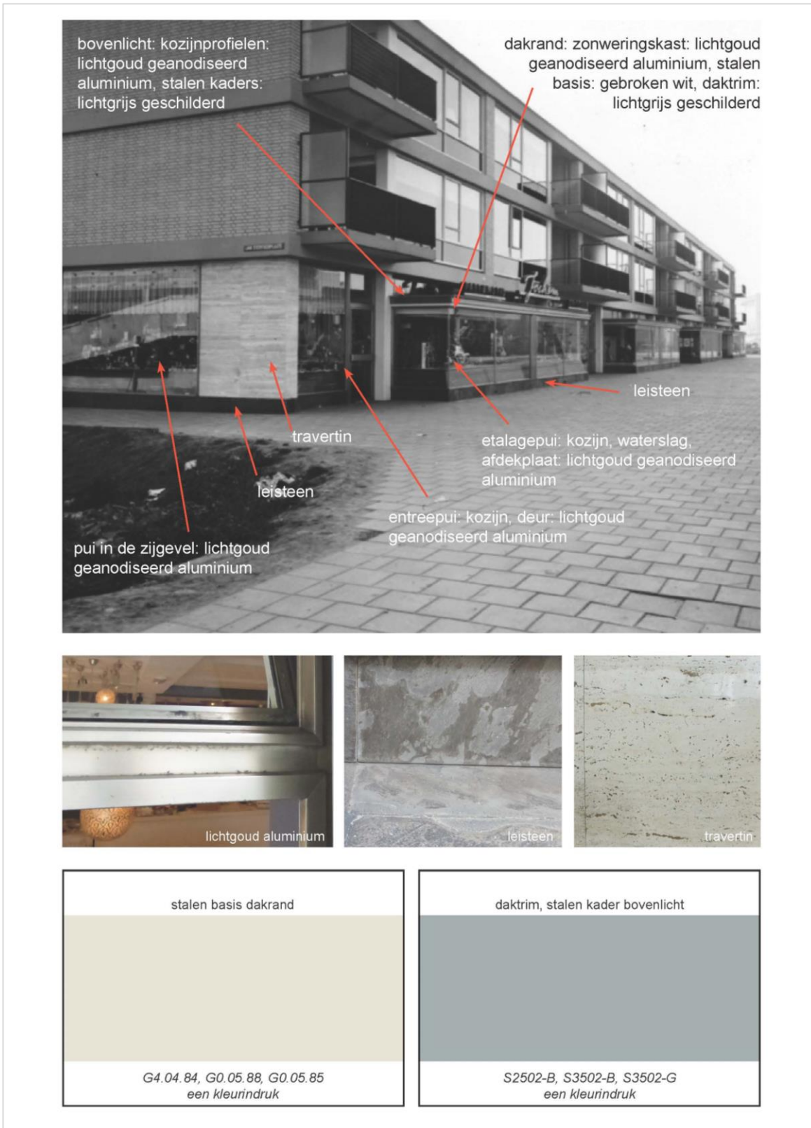
Fig. 6. Naast het onderzoek van verflagen worden ook de kleuren van het in het gebouw gebruikte materiaal bij het kleurhistorisch onderzoek betrokken. Kleurbenadering bij het Verkennend kleuronderzoek Karel Doormanstraat 320-330, W. van Tijen en H.A. Maaskant, Rotterdam.
