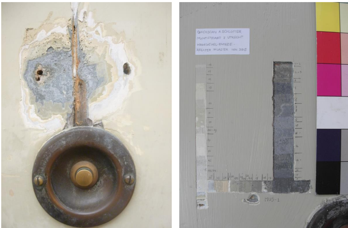
Fig. 3. Kleuronderzoek op een deurkozijn aan de Muntstraat te Utrecht; links een soort toverbal vervaardigd als onderdeel van een inventarisatie en rechts een kleurentrap vervaardigd bij een verkennend kleurhistorisch onderzoek waarbij meer dan 40 verflagen onderscheiden zijn.
