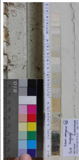
scheidslijn oud en nieuw kozijn
