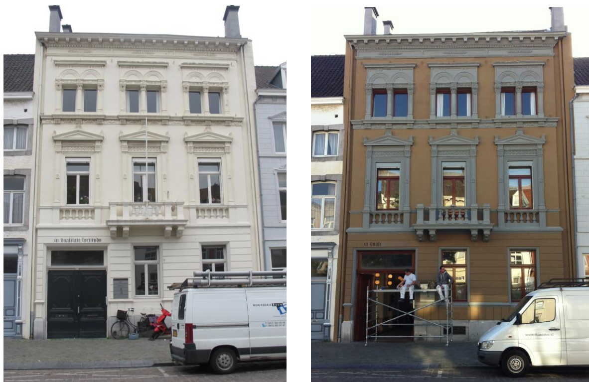
Fig. 5. Voorbeeld van het resultaat van een verkennend kleuronderzoek. De gevel wordt opnieuw in de teruggevonden 'oude' kleurstelling geschilderd.
